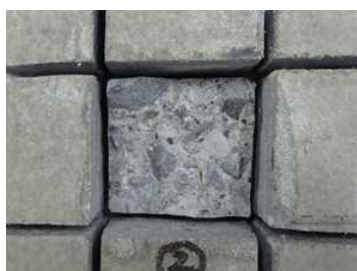
(a) 母材コンクリート破壊
