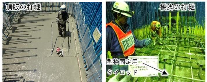
写真-2 再振動の状況 (左:サーファー 右:マジックタンパ)
