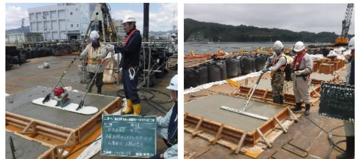
写真-1 供試体の製作状況(左:サーファ- 右:マジックタンパ)
