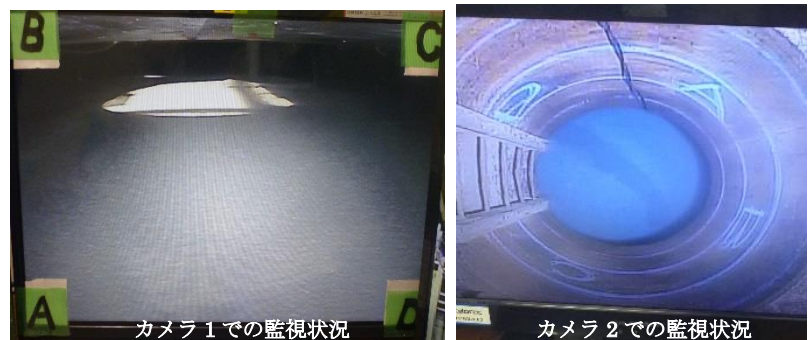
写真-2 打込み箇所の流動・充填状況確認
