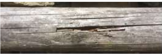
写真4 加圧処理材 (築2年)
