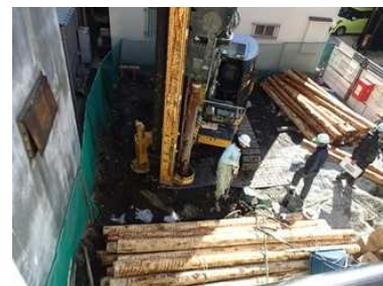
写真-2 LP-LiC 工法施工状況
