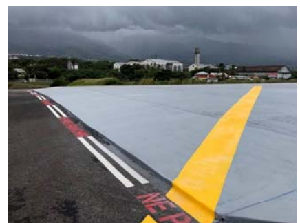
図1 路面標示による誤進入防止事例
