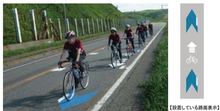
図-6 路面表示（矢羽根）と設置状況（国道238号稚内市）
