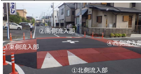
図2 交差点ハンプ設置状況
