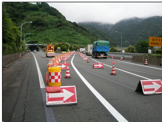
図-1 高速道路における車線規制
