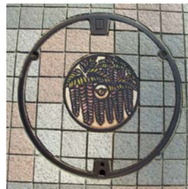
写真-3 効果を発揮した敷設
