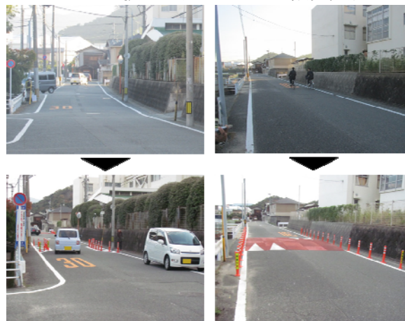
図-2 狭さく及びハンプの設置状況
