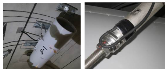
写真-1 軸力計測状況
