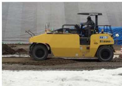
図-5 タイヤローラによる転圧
