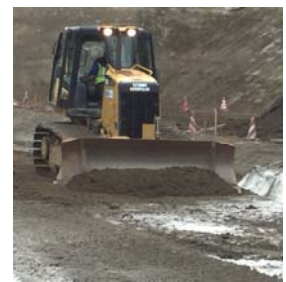
図-4 ブルドーザ による整形・予備転圧
