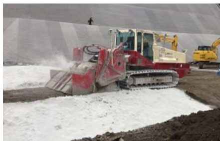
図-3 スタビライザによる 混合・攪拌
