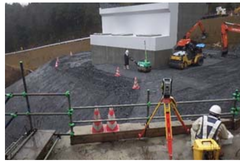
写真-1 対象範囲（橋台前面の狭隘部）
