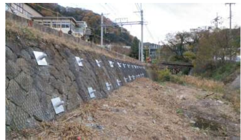
図-4 補強完了後の現場状況
