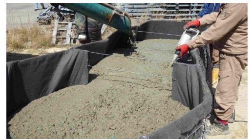
写真-3 コンクリート打設状況
