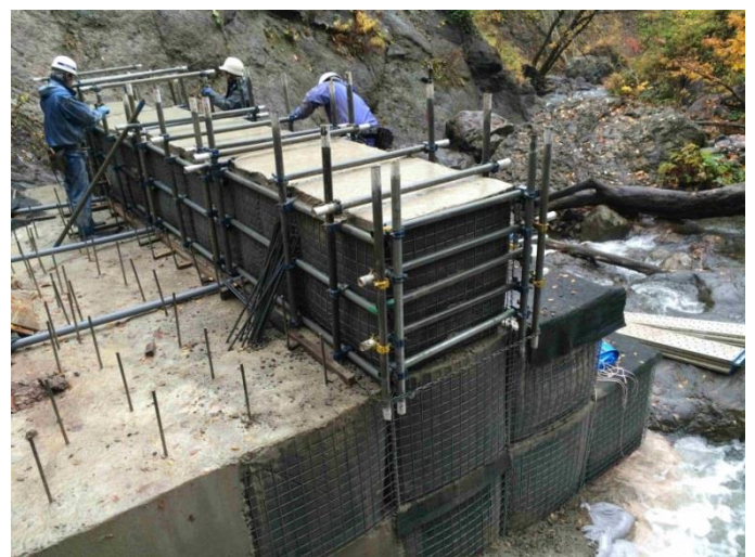
写真-1 抑止工（コンクリート擁壁）の残存型枠使用例
