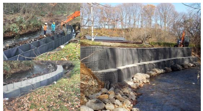
写真-4 試験施工状況
