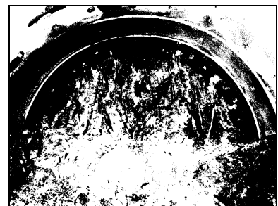
図3 画像処理後のトンネル切羽画像
