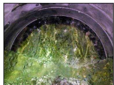
図2 画像処理前のトンネル切羽画像
