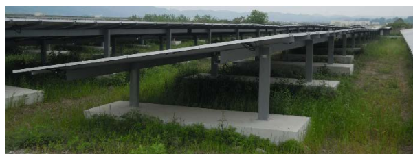
写真2 アレイ架台写真（直接基礎形式）
