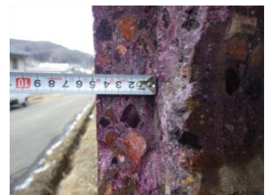
写真-2 壁面中性化試験(調査箇所 1)
