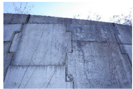
(c) 壁面材状況(調査箇所 1)
