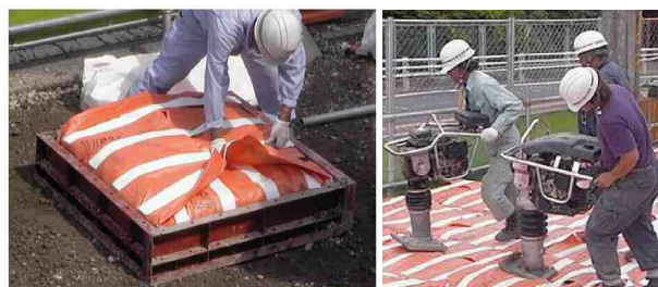
①一定量の中詰材を投入・閉口 ②敷設してランマーで転圧
