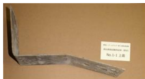
写真-1 採取した壁面材接続金物（No. 1-1）
