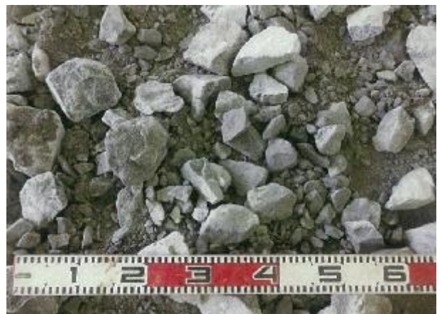
写真1 裏込め材の状況
