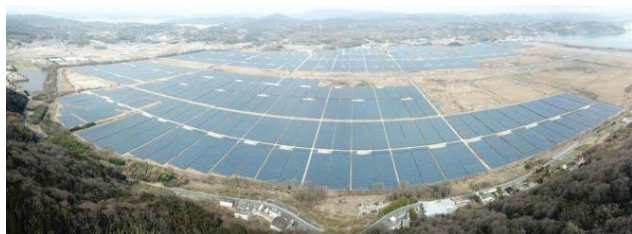
写真1 瀬戸内 Kirei 太陽光発電所 全体写真
