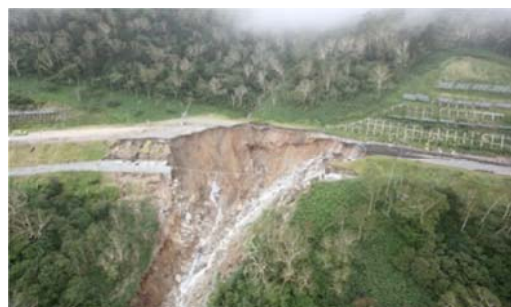
写真 2 盛土崩壊箇所
