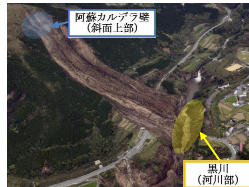
図-1 南阿蘇村立野地区の斜面崩壊 1)
