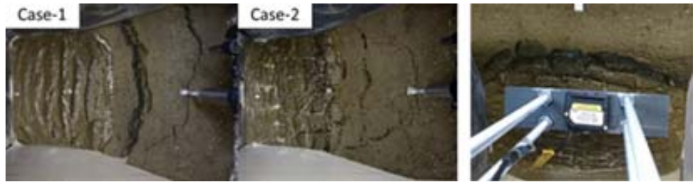
図 4 のり肩が崩壊した時の様子 (右側がのり肩、上方から撮影)
