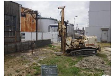
写真 3.2 フェントン反応剤注入状況
