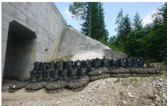
写真-3 応急対策後状況
