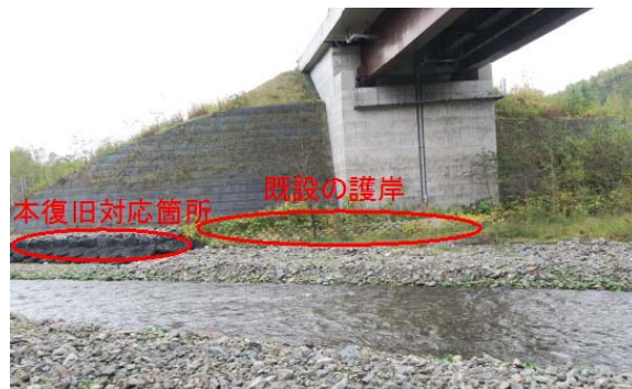
写真-4 下トマム鵠川橋
