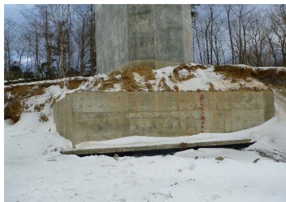
写真-5 串内橋橋台部
