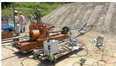
図-3 水平ボーリングマシンを用いた貫入実験
