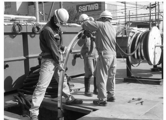
写真-1 凍結管建込状況
