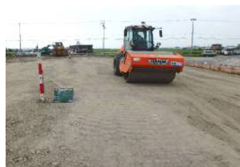
写真-4 締固め(振動ローラー)
