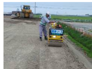
写真-5 締固め(ハットローラー)
