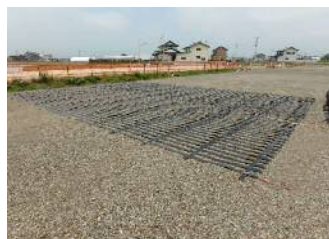
写真-2 敷網敷設
