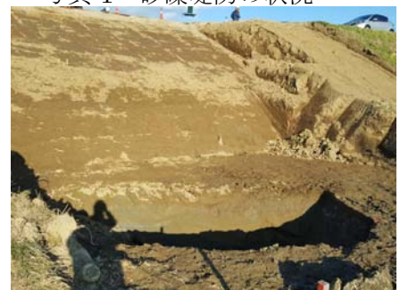
写真 2 粘性土堤防の状況
