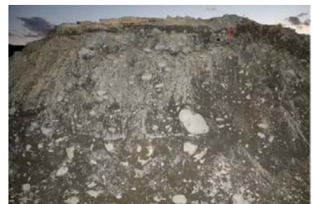
写真 1 砂礫堤防の状況
