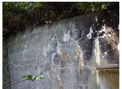
写真-4 アルカリ骨材反応による ウイングのひびわれの例
