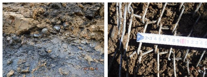
写真-1 盛土内湧水状況【左】・敷網工状況【右】
