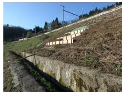
写真 - 5 応急対策の状況
