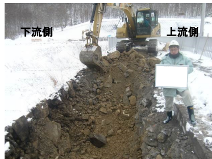
写真-1 ダム天端のトレンチ掘削状況
