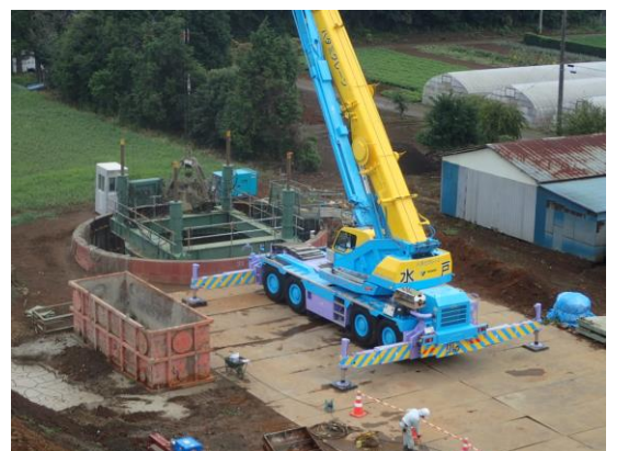
写真1 アーバンリング施工状況
