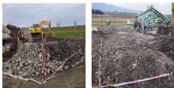
写真-2 巨石及び草根等分別・除去状況(H27)
