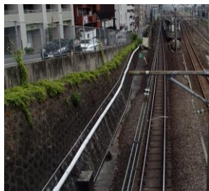
写真2 耐震補強箇所
