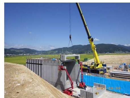
写真-4 ボックス据付状況
