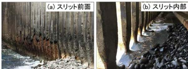
写真-1 スリット式護岸の摩耗状況
