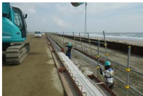
写真-1 型枠撤去・設置
