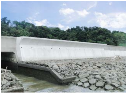
写真1 上部フレア施工事例
