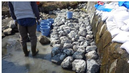
写真6 上段の施工補強された1層目の石組み魚道
