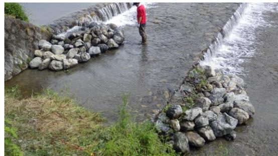
写真2 初回に実施した石組み魚道の設置状況（5月）
