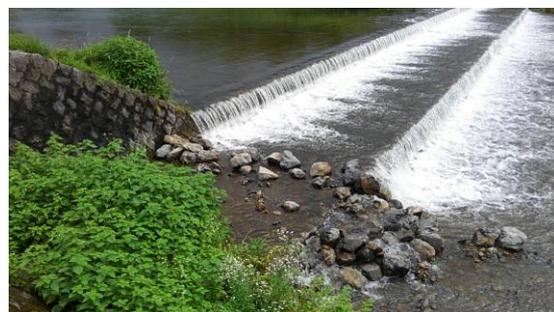
写真4 越流水深1m規模の出水で石組みが崩壊された状態（7月）
