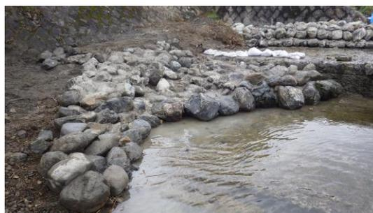
写真8 下段の完成した石組み魚道
