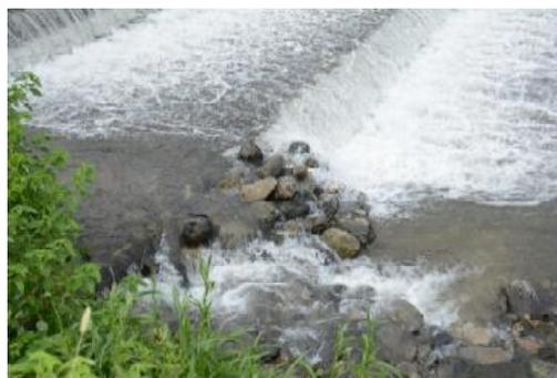
写真5 補強された下段の石組み魚道
