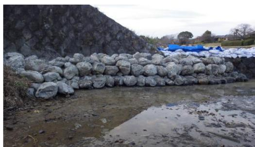
写真7 上段の完成した石組み魚道
