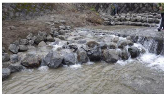
写真9 下段に設置した石組み魚道内の流況
