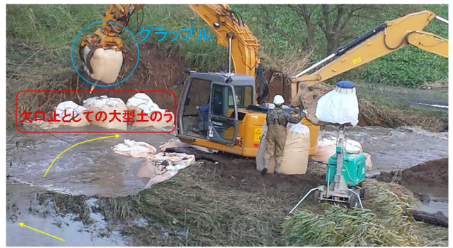
写真-2 締切作業を行っていない側への大型土のうの投入
