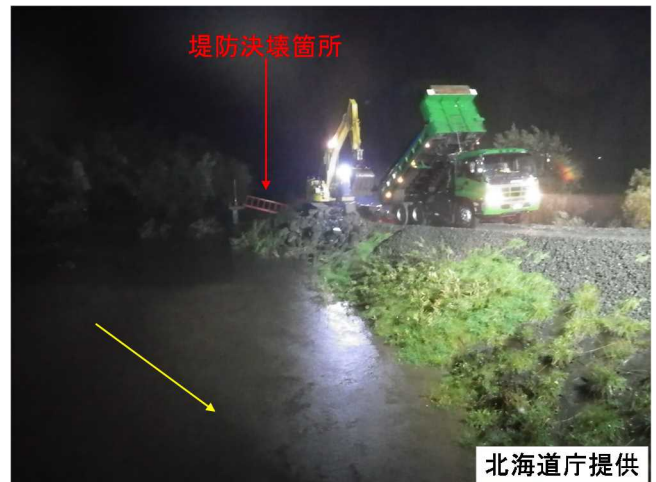
写真-1 天端拡幅後に天端にバックで進入するダンプ
