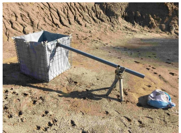
写真-1 箱型鋼製枠による釜段工
