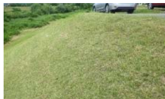
図-1 ノシバによる堤防管理(雄物川)
