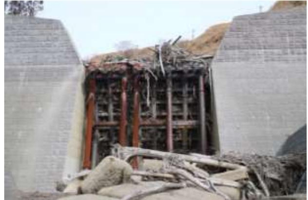
写真-1 鋼製砂防堰堤
