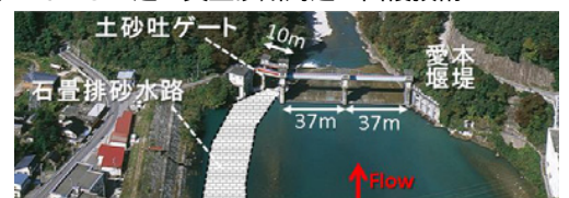
図-2 愛本堰堤の土砂吐位置と石畳排砂水路
