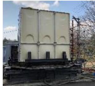
写真-1 FRP製貯水槽
