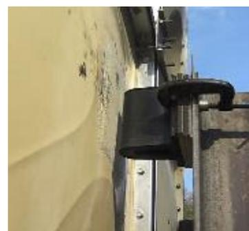
写真-6 ダンパーとタンク壁面に生じる隙間
